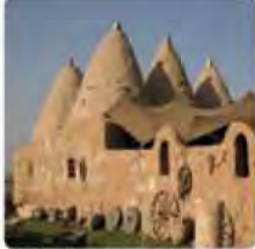
Görsel 14. Kerpiç ev (Gaziantep)
